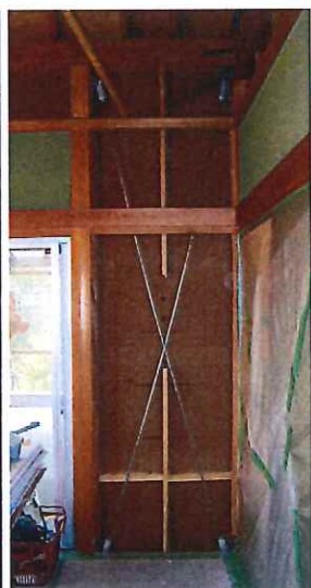
長押を残した補強例
