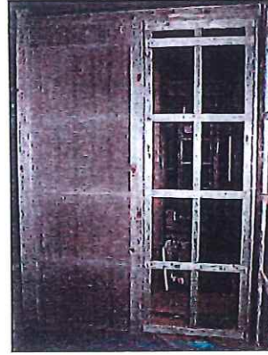
受け材、面格子下地取り付け
