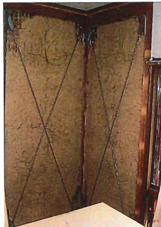
3. コボット・ステンブレース取付 コボットにステンレス製ブレースを取り付けます。
