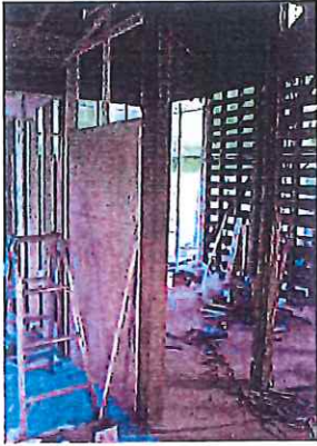
壁パネル取り付け
