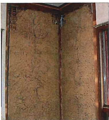
2. コボット（端部金物）の取付 土壁の一部を削って壁の端部にコボットを専用コーチスクリューで固定します。
