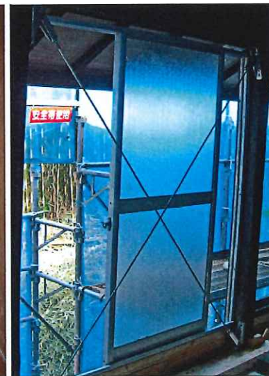
大開口部の補強例
