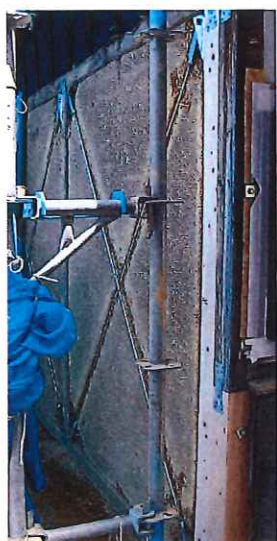
外壁の補強例
