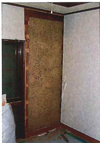
1. 仕上げ材撤去
