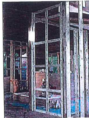
受け材、面格子下地取り付け
