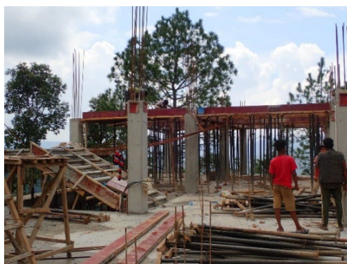
ネパールでの災害に強い学校づくり
